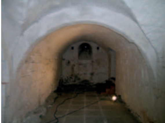
Forhvelvet før restaurering.
