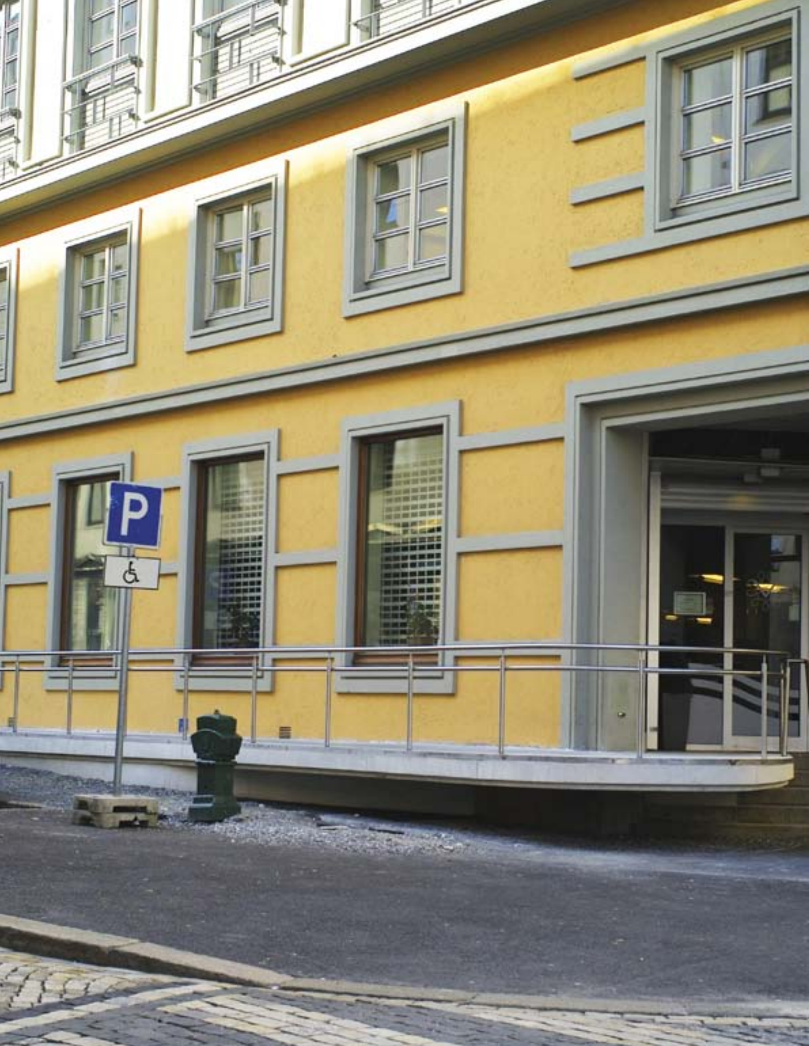
Rampen under bygging. Foto: Bergen kommune
