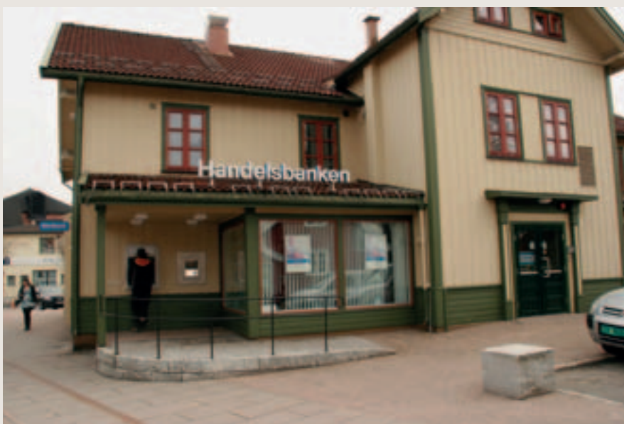
Veiberggården Jessheim. Tilgangen til minibanken sikres via en lav rampe som utnytter høydeforskjellen i terrenget ved huset. Foto: Ullensaker kommune
