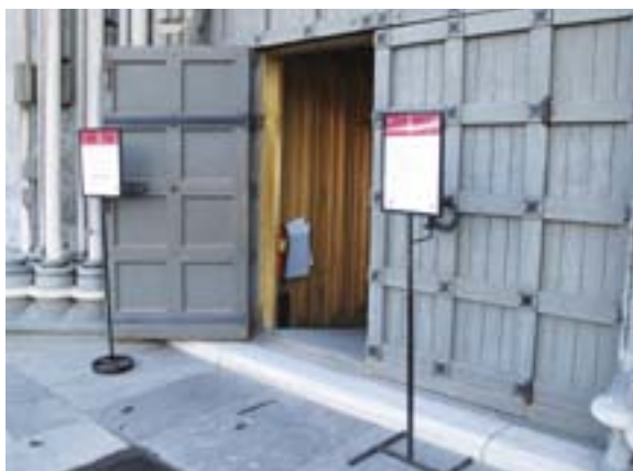
Hovedinngang vestfronten. 10 cm. nivåforskjell inn til kirken. Innvendig rampe innenfor døråpning.
