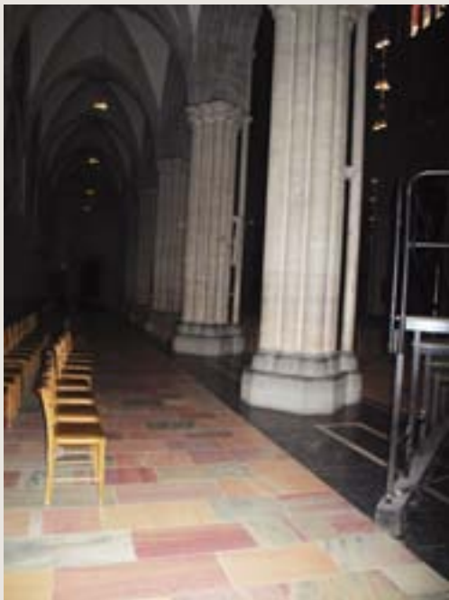
Eksisterende bygg kan ha kvaliteter som ivaretar enkelte krav til universell utforming. Her er et eksempel på en naturlig ledelinje i Nidarosdomen. God kontrast i eksisterende marmorgulv. Foto: Trondheim kommune
