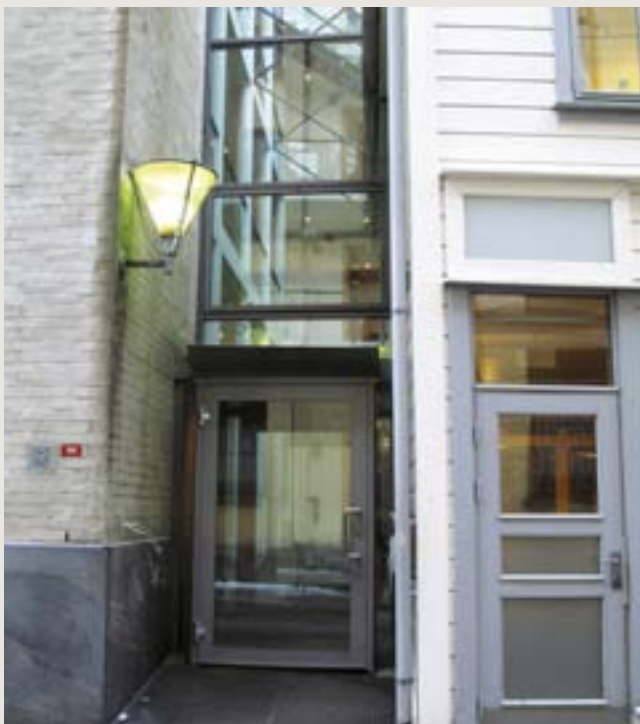
Ny heis i Bergen. Det kommer tydelig frem at heisen er et nytt element, fra en annen tidsperiode enn bygningene den betjener. Foto: Trondheim kommune
