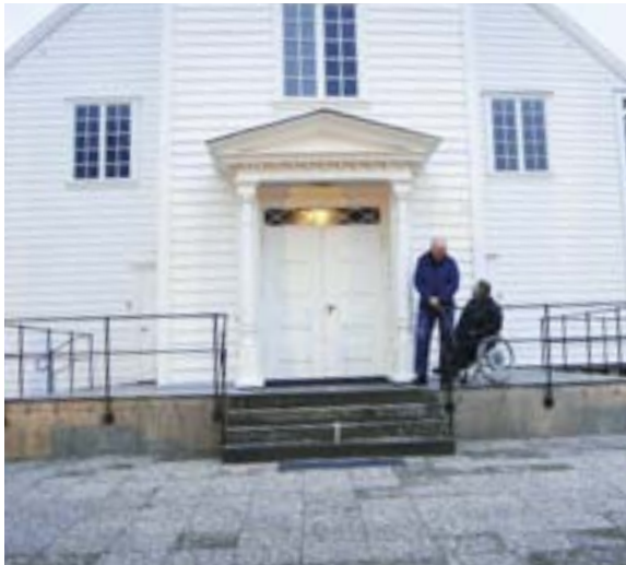
Trapp og rampe møtast framfor hovuddør. Trinnfri atkomst. gir ein hovedinngang for alle.
