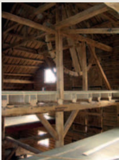
Kjøpmannsgata 37 under ombygging fra lager til kontorbygg. Bygget ligger i bryggerekken mot Nidelva i Trondheim.
