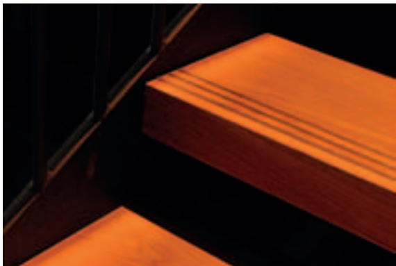
Kontraster mellom trinn og vange bidrar til å synliggjøre trappeforløpet. Nedfelt messinglist markerer trappeforkanten.
