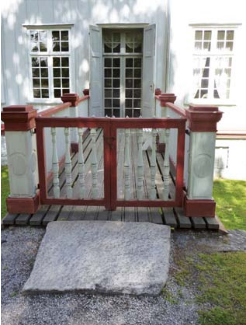
Den originale hageutgangen på byggets sørside brukes som inngang for rullestolbrukere, samt til daglig bruk ved mange besøkende. Ledsager er nødvendig for brukere av rullestol.
