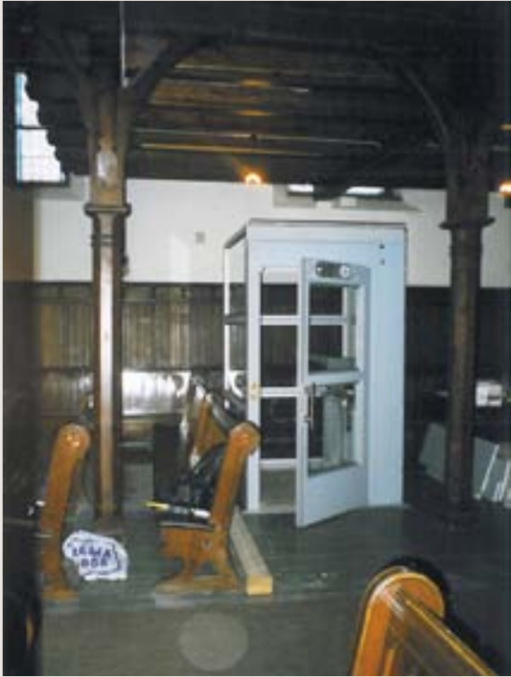
Heis under bygging før kledning med trepaneler. (uriktig fargegjengivelse)
