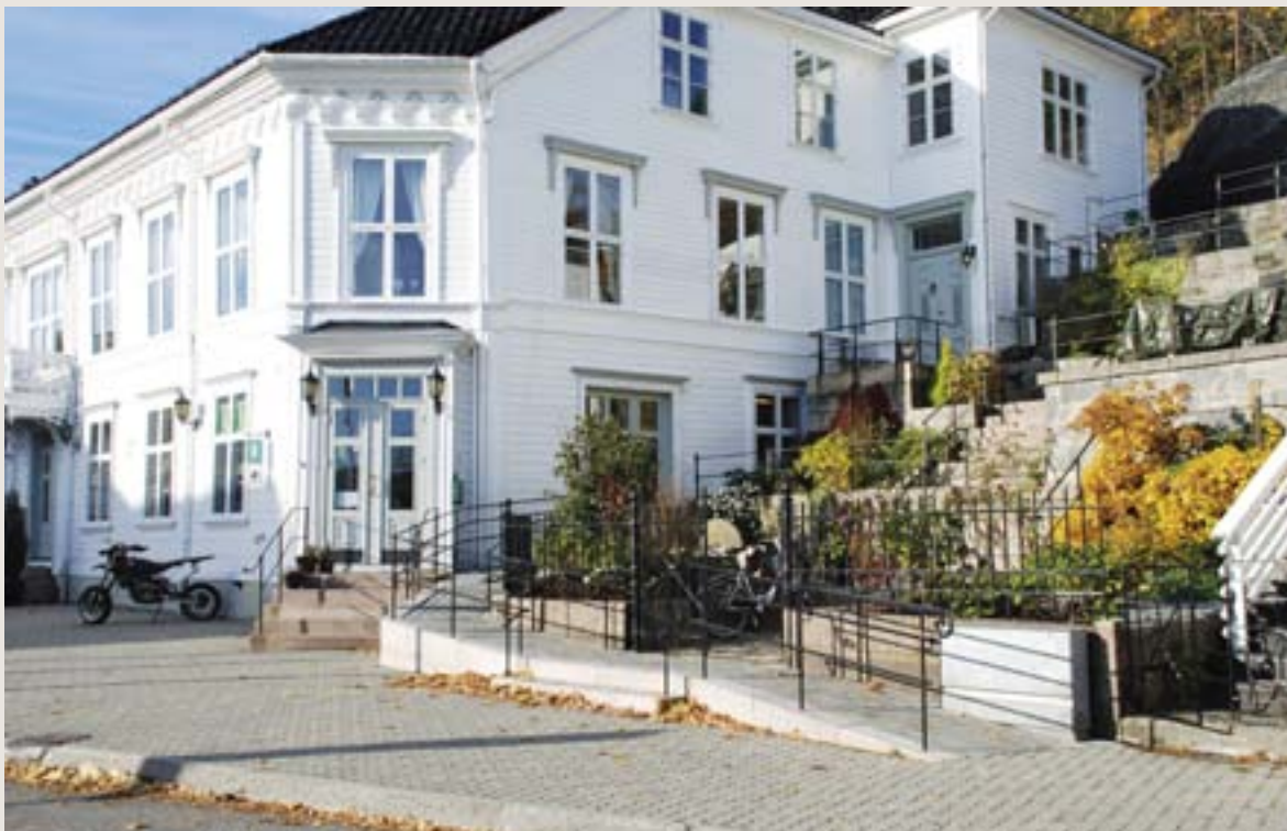
Ny rampe og inngang.
