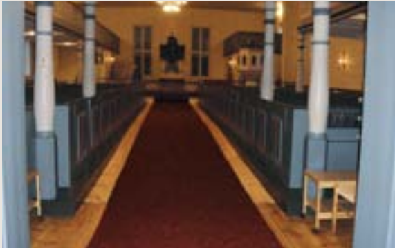
Det er lagt rampe oppå eksisterande golv. Det er merking for teleslyng.
