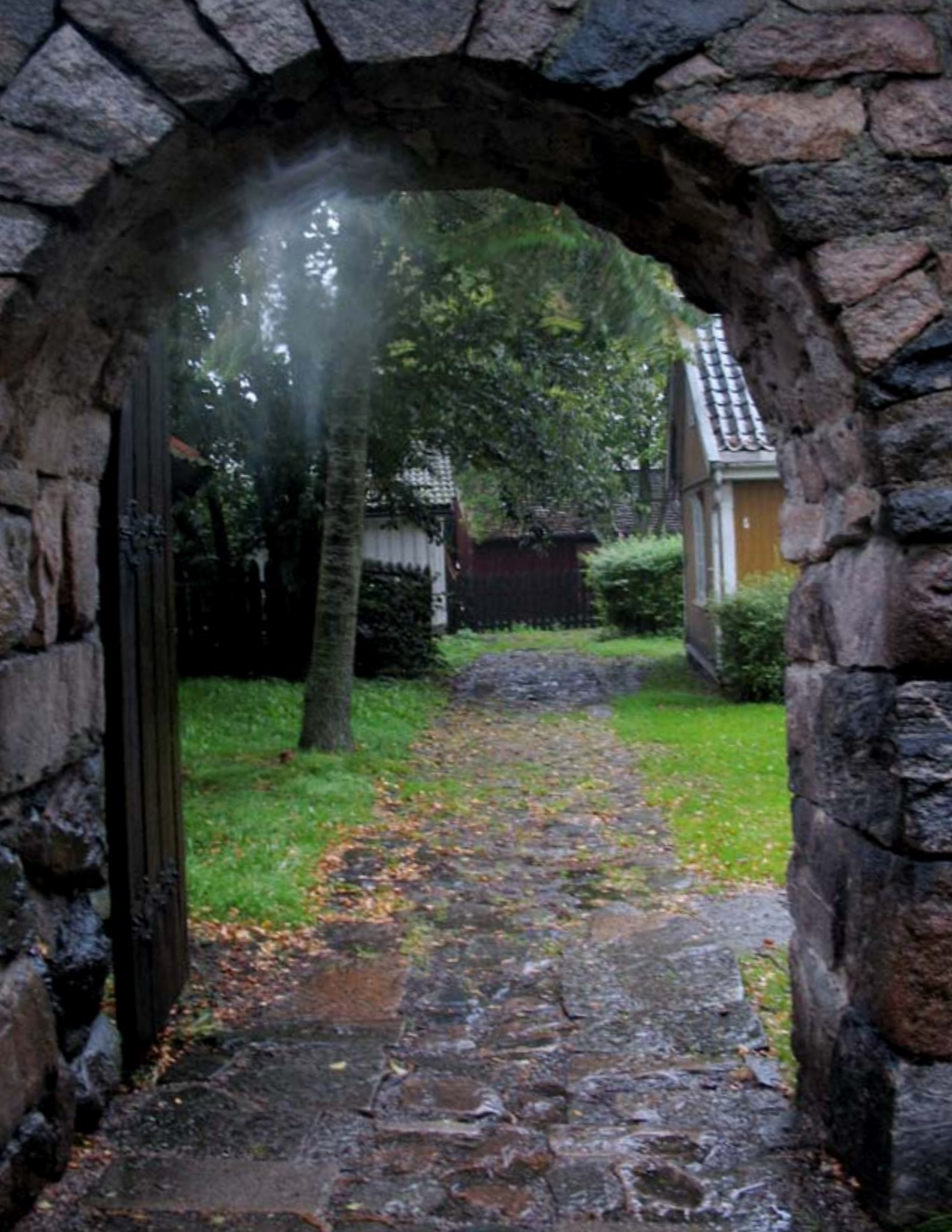
Opprinnelig atkomst med svært ujevnt dekke.
