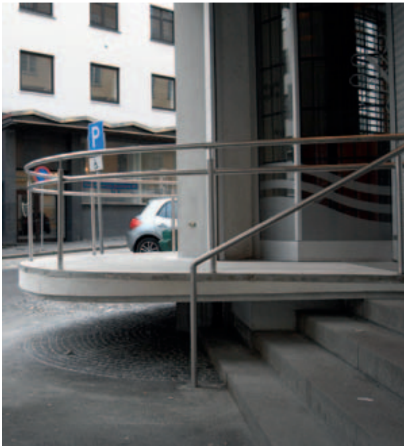
Rampen er ferdig. Merk den taktile overflaten under rampen (innspill fra Blindeforbundet). Foto: Bergen kommune
