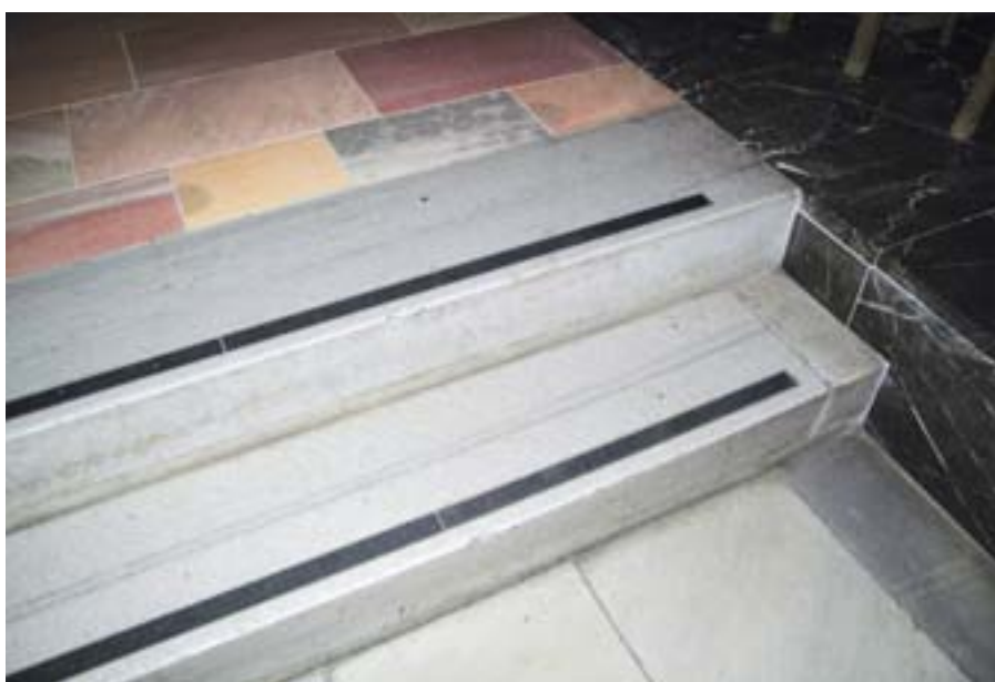
Markerte trappetrinn. Frest spor ytterst på trappetrinn, ilagt farget materiale.
