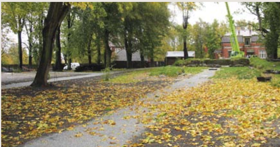
Gangveien har nå fast grusdekke og tydelig kantavgrensing mot gresset.
